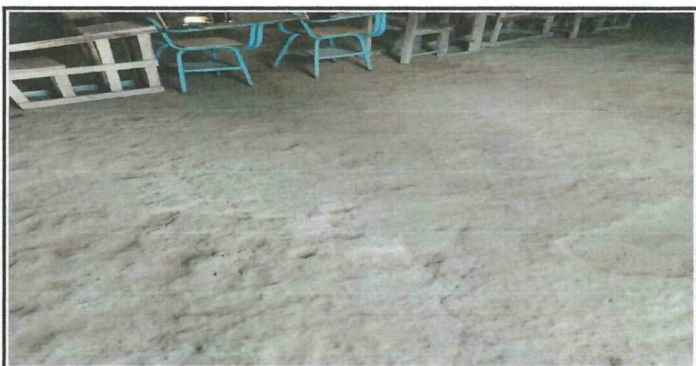
Foto 6: SUSTITUCION DE PISO DE CONCRETO
