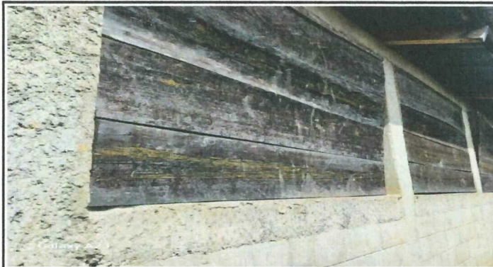
Foto 2: SUSTITUCION DE VENTANAS Y BALCONES
