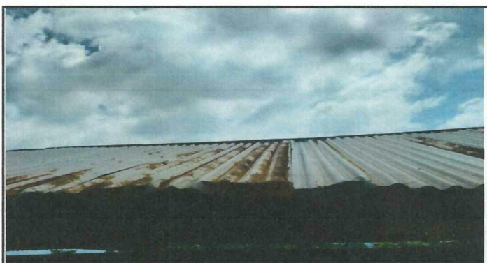
Foto 4: SUSTITUCION DE ESTRUCTURA DE TECHO Y CUBIERTA DE LAMINAS
