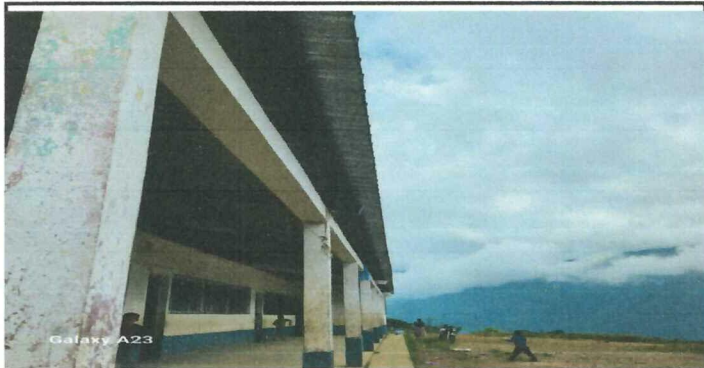
Foto1: SUSTITUCION DE CANAL DE AGUA PLUVIA
