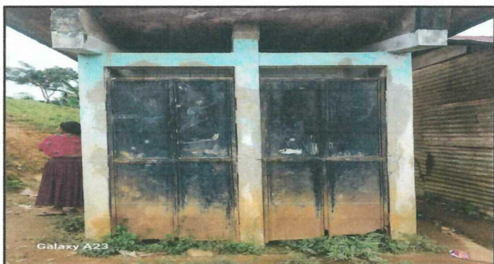
Foto 3: SUSTITUCION DE PUERTAS DE BAÑOS
