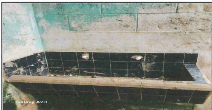
Foto 5: SUSTITUCION DE LAMANOS DE CONCRETO
